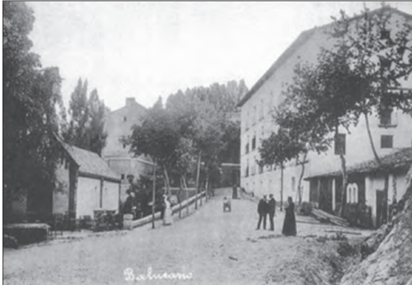
Figura 17. Antigua edificación del Balneario Sicilia (Jaraba).
