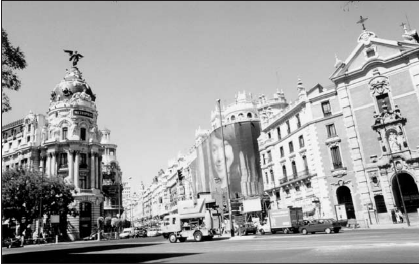
Fotografía 4. Inicio de la Gran Vía en la calle de Alcalá. A la derecha, Gran Peña (1914-17), en rehabilitación, Gran Vía, 2., de Eduardo Gamba y Antonio Zumárraga (Historicismo ecléctico).. A la izquierda, esquina Gran Vía y Alcalá, Edificio Unión y El Fénix-Metrópolis (1907-1910), de Jules y Raymond Fevrier (Historicismo ecléctico).
