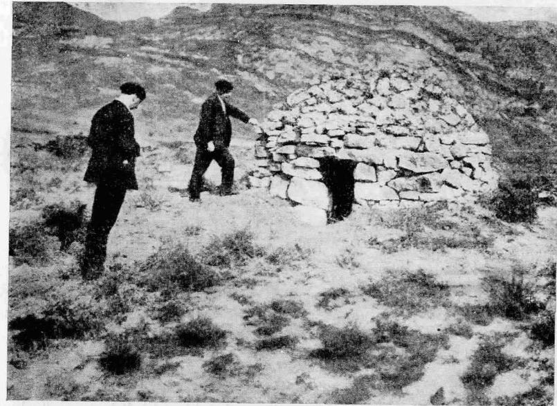
Fig. 4.—Cabaña refugio alavesa con cubierta en forma de cúpula.
