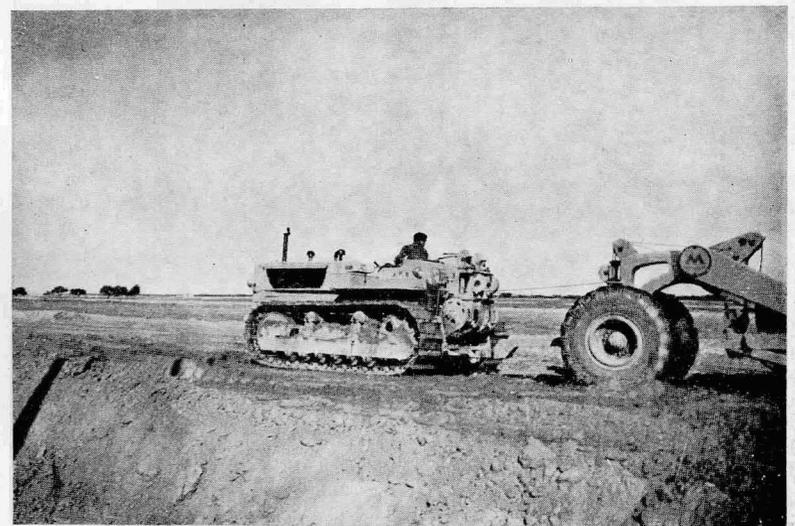
Fig. 19.—Máquinas desfondadoras actuando en la primera parte de Montijo.
